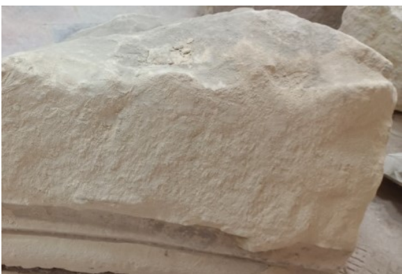
LAP.2023.110 – Détachement de fragments de pierre.
