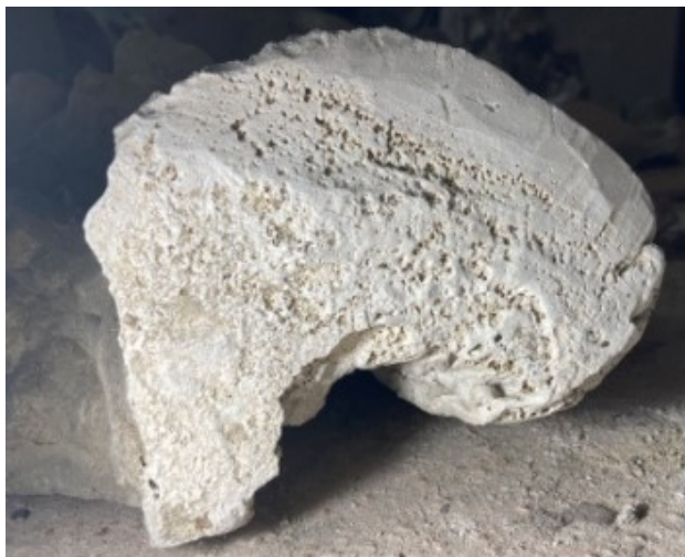
M15 -Partie dissoute sous le moulage.
