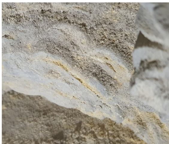
A6 - Autre exemple de désagréation active.
