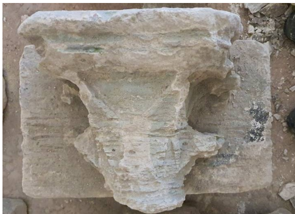
B8 - Erosion mettant en évidence le lit de la pierre.
