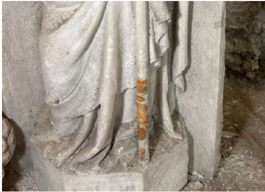
M11 – Armature oxydée ayant tachée le plâtre.
