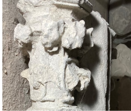
F22 – Surface recouverte de mortier.
