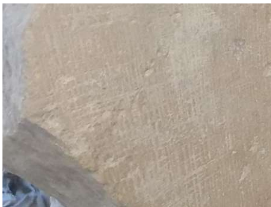
E7 – Taille ciselée (croisée) sur l'une des faces.
